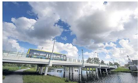
De busbrug tussen Westervatering en Westervoog.
